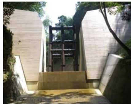
【県】大谷川 鋼製透過型堰堤
