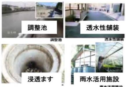
雨水貯留浸透施設の例
