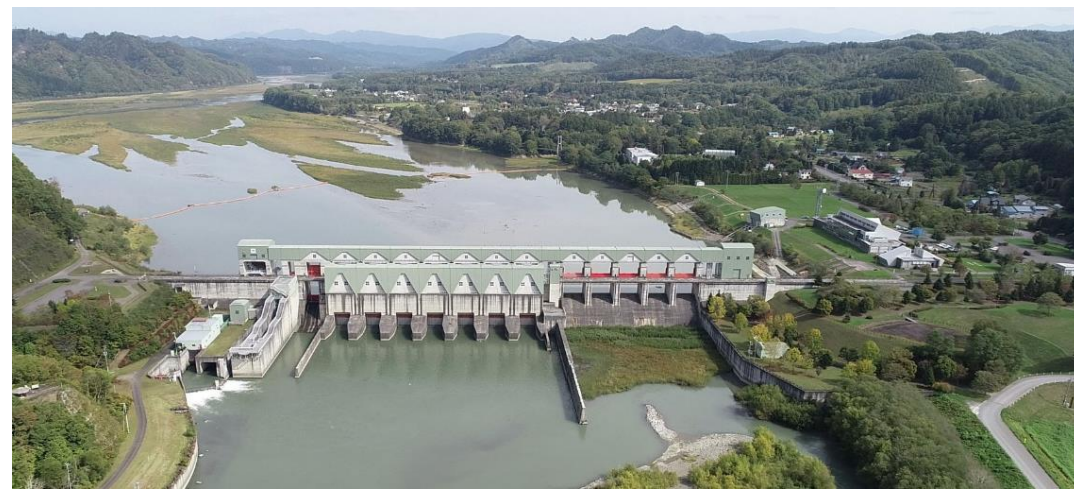
洪水期の二風谷ダム空撮 2021年9月28日撮影
