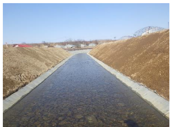
農業整備事業(排水路整備:宮戸幹線明渠)
