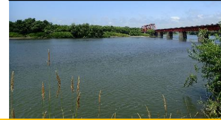
KP1.8付近(令和5年撮影) 保全区間
