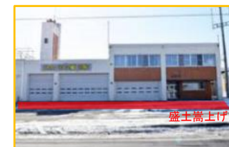
消防庁舎の嵩上げ(むかわ町)
