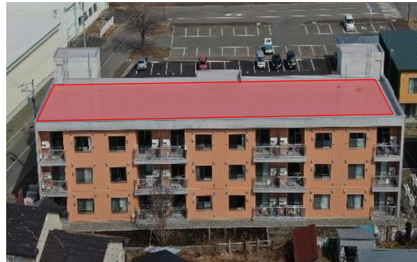
町営住宅の屋上を活用した避難場所の設定(むかわ町)
