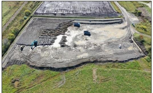
・河道掘削土の有効活用として、流域の農地へ運搬している。運搬先の農地では降雨の際の浸水被害の軽減のほか、浸水後の排水不良の軽減、隣接農地との標高を揃えることにより使いやすさを高めること等の効果を期待。
