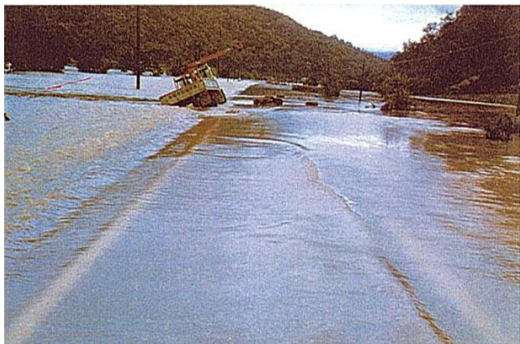
天塩川左岸 箴島左岸築堤の溢水氾濫状況(音威子府村) (出典: 天塩川流域委員会資料)
