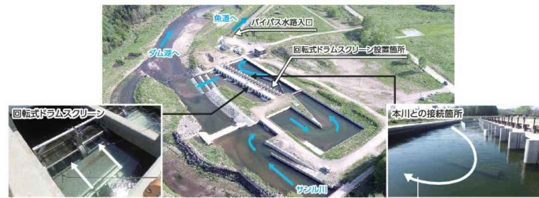
写真-1 本川との接続箇所(本川から魚道への誘導施設)
