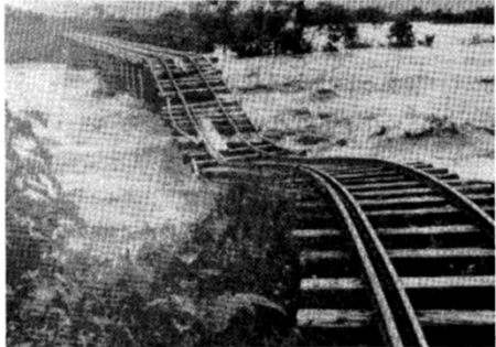
士別軌道天塩川九十九橋の流出 (出典: 天塩川治水史)
