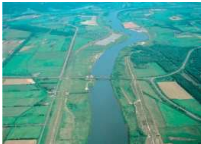
下流部の状況
