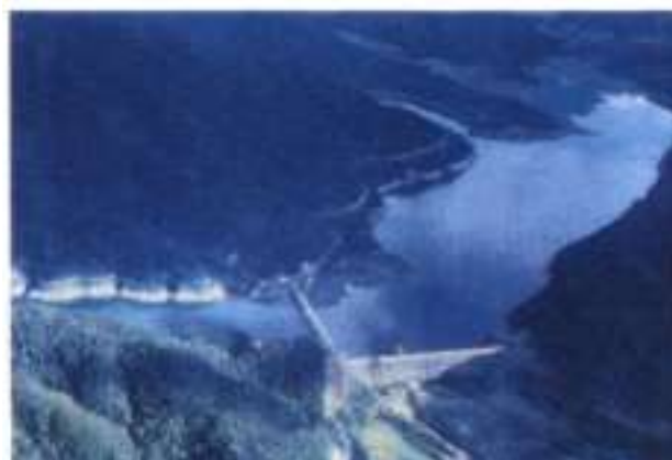
昭和 46 年に完成した岩尾内ダム
