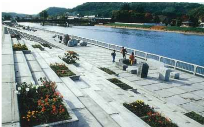
景観に考慮した護岸（下流部）
