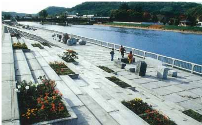
景観に考慮した護岸（下流部）
