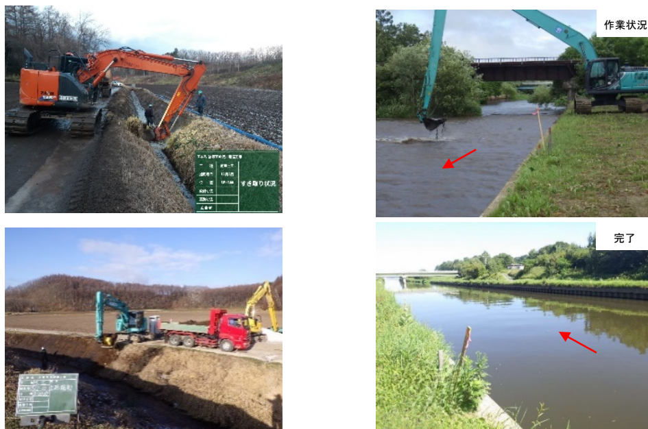
写真 4.3 治水安全度向上のための掘削等の事例
