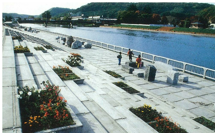
写真 4.1 景観に考慮した護岸（下流部）
