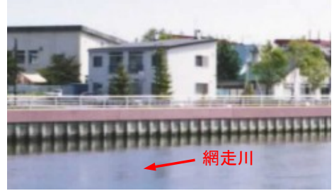
②網走湖下流部の矢板護岸整備 (中央橋上流右岸) (昭和53年～平成3年整備)
