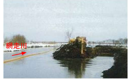
③中流部の堤防整備 (昭和54年～昭和55年整備)
