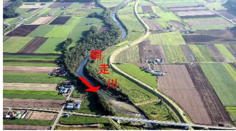
④河道掘削(網走湖～美幌川合流部) (昭和62年～平成5年整備)
