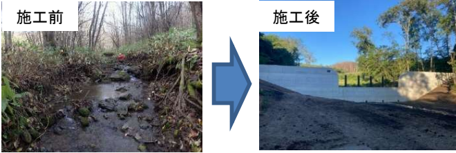
治山ダム整備状況
