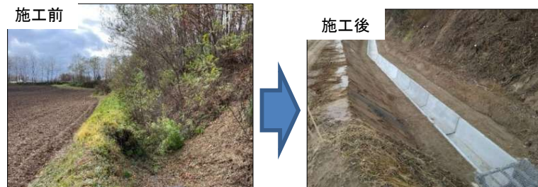
農業排水路整備状況
