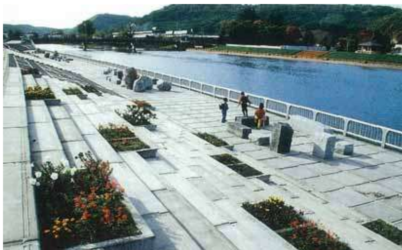
景観に考慮した護岸（下流部）
