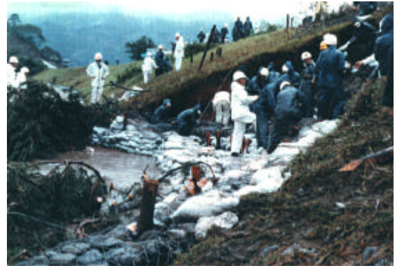
昭和 57 年 8 月災害 蛇籠・土嚢による応急工事 (12.0k 付近左岸：福田ヶ谷地先)
