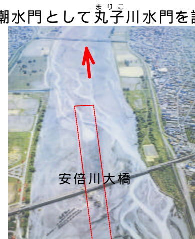
緊急河道掘削 (安倍川 7.0k 付近)
