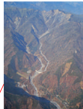
大谷床固工群、大島砂防えん堤 及び大島流路工
