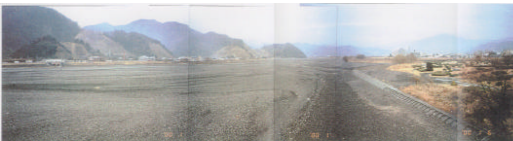
狩野橋上流（全面枯渇）
