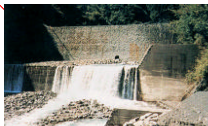
金山砂防えん堤（S31.1 完成）
