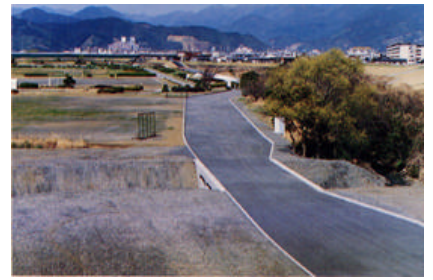
③緊急用河川敷道路
