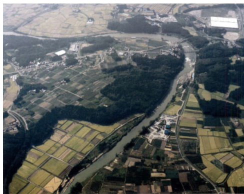
阿武隈川上流域では、沿川に水田と樹林地が交互に接しており、流れは瀬淵を創り出している。
