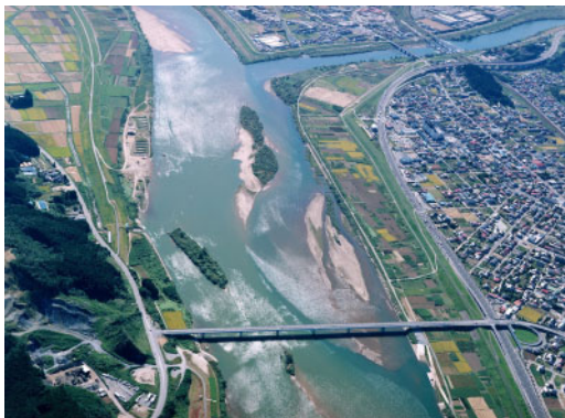
下流域では、広い高水敷が見られ、オギ、ヨシ等の群落形成されている。
