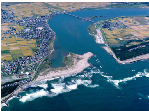
河口部にはワンドが形成され、カモメの集団場等になっている。左岸側には貞山運河が見られる。
