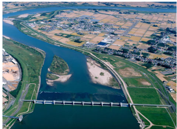
代表的な河川構造物 阿武隈川大堰
