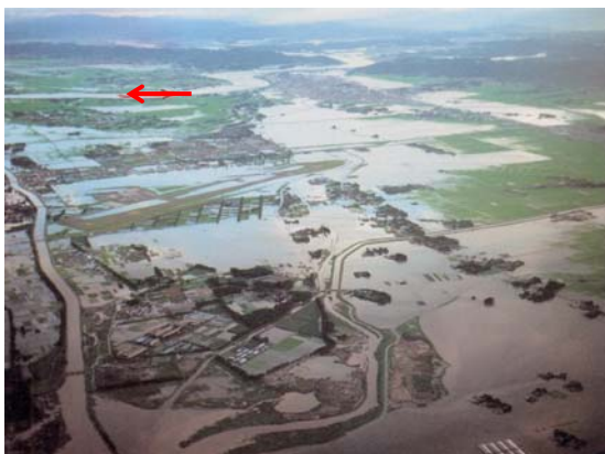
仙台空港周辺（岩沼市）の浸水状況
