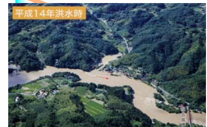
平成14年洪水時 宮城県 福島県県境の狭窄部における 出水時の状況比較
