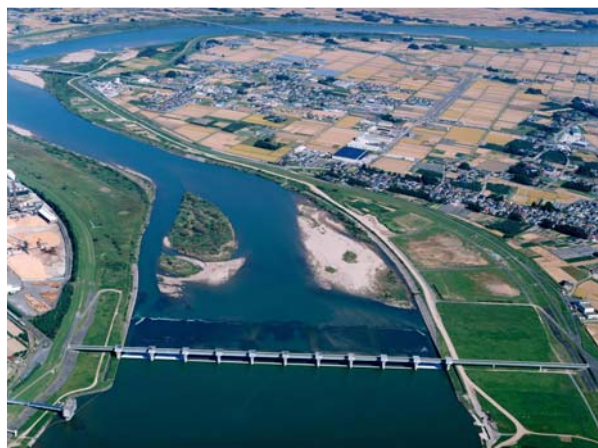
代表的な河川構造物 阿武隈川大堰
