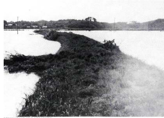
平成 28 年 6 月 20 日の岩沼市（福島県）の浸水状況
