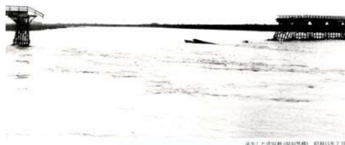
「洪水により流出した菅原橋」(鶴岡市日出付近)
