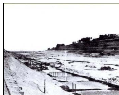
放水路開削工事の様子 (昭和8年)
