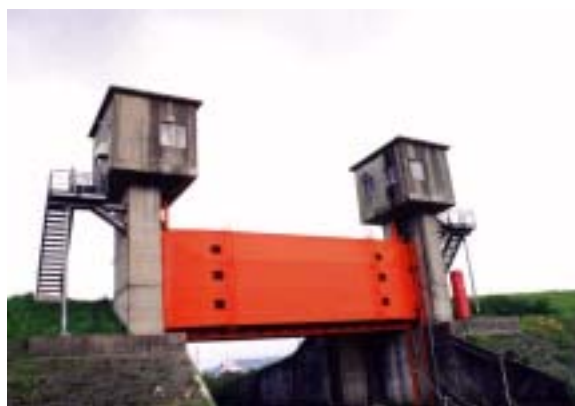
赤谷川制水門（関川村打上）
