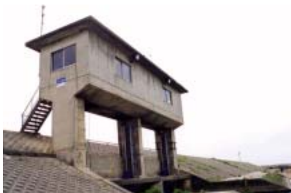
乙大日川樋門（荒川町海老江）
