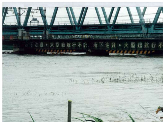
写真 4-12 京成押上線橋梁の洪水写真
