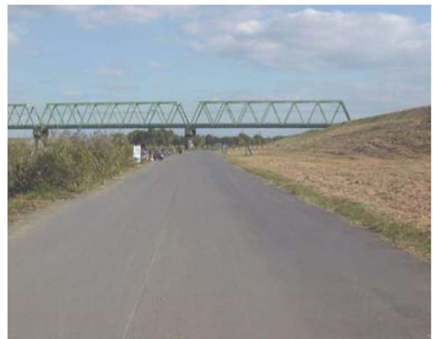
写真 9-9 緊急用河川敷道路（JR 武蔵野線付近）
