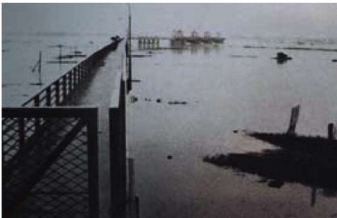
写真 4-6 秋ヶ瀬取水堰（志木市）
