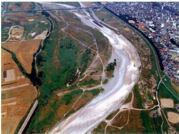
写真 5-5 熊谷付近の瀬切れの状況 (平成 4 年)
