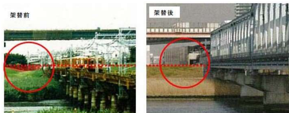
写真 4-22 京成押上線の架け替え
