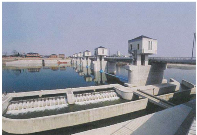
写真 5-4 六堰頭首工と流水改善水路（手前）
