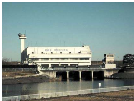
写真 4-16 南畑排水機場
