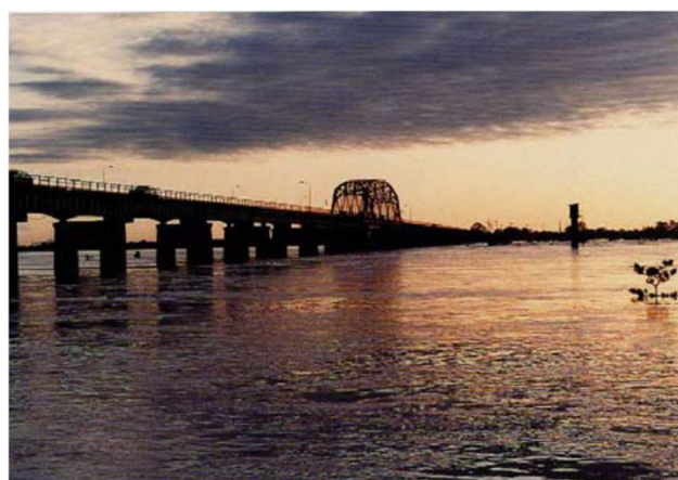
写真 4-8 治水橋（さいたま市）
