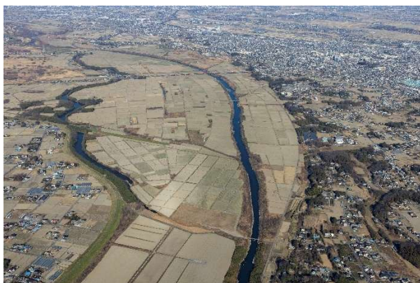
写真 8-6 御成橋付近 (62.0k 付近)
