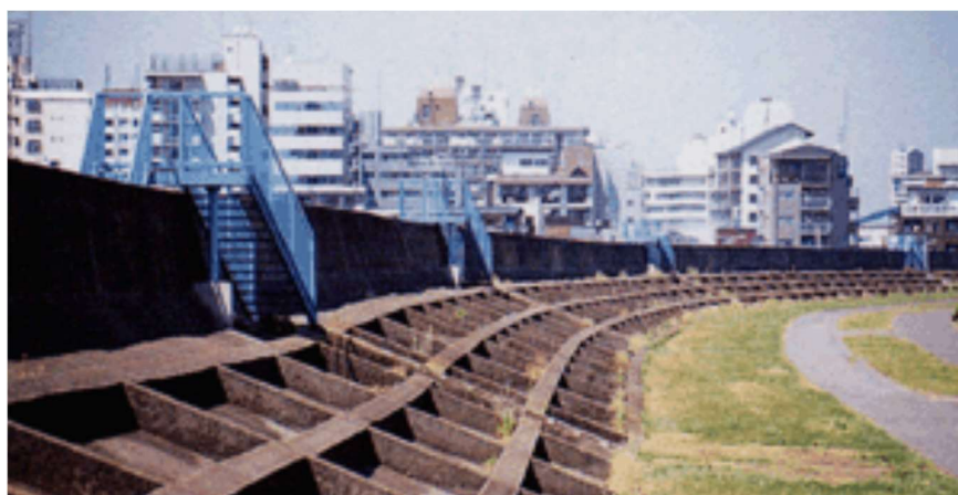
写真 4-23 荒川の高潮堤防
