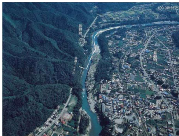
写真 8-3 長瀬（109.0k 付近）
