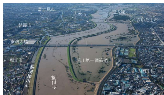
写真 4-15 荒川第一調節池での洪水調節状況
