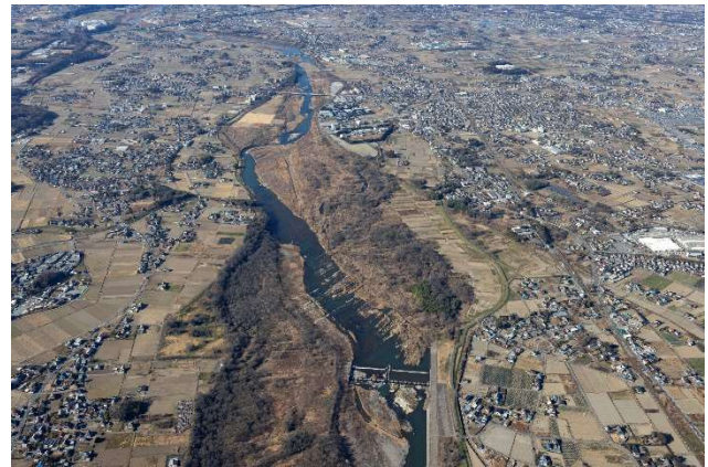
写真 8-5 明戸床止め (84.0k 付近)
