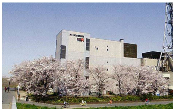
写真 9-23 荒川知水資料館
