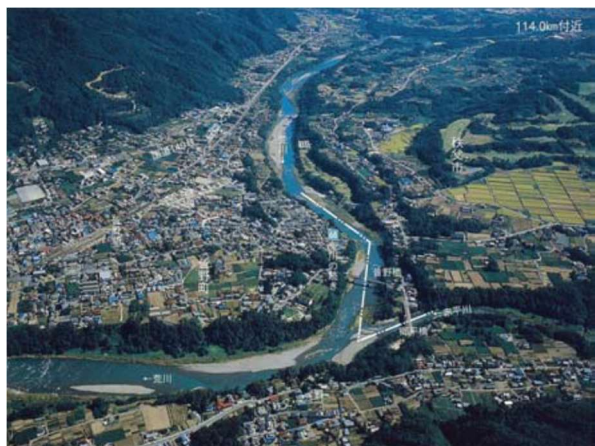
写真 8-2 赤平川合流部（114.0k 付近）
