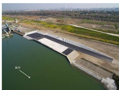
水上輸送の拠点となるリバーステーション (あきがせ緊急用船着場(リバーステーション))
