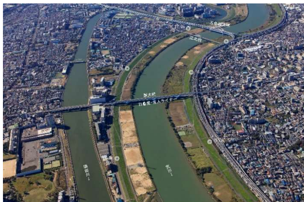
写真 8-8 扇大橋 (15.0k 付近)
