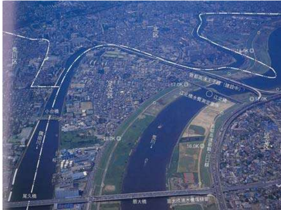
写真 8-9 扇大橋（15.0k 付近）
