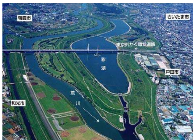
写真 4-18 荒川第一調節池（彩湖）
