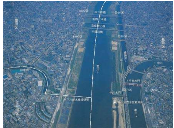
写真 8-8 京成押上線下流（7.0k 付近）
