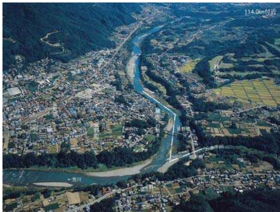
写真 8-2 赤平川合流部（114.0k 付近）
