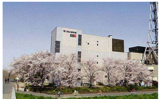
写真 9-23 荒川知水資料館
