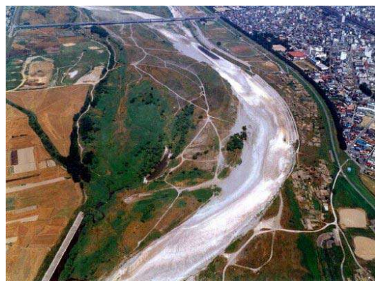
写真 5-5 熊谷付近の瀬切れの状況 (平成 4 年)
