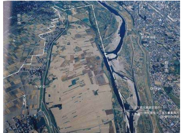
写真 8-5 久下橋（74.0k 付近）
