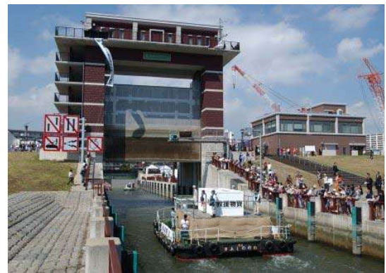
写真 7-6 荒川ロックゲート
