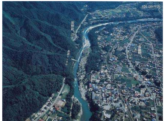
写真 8-3 長瀬（109.0k 付近）
