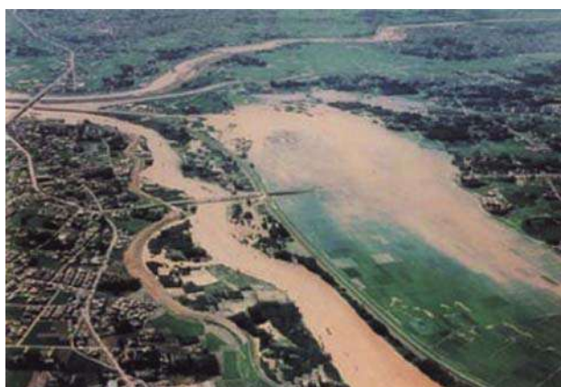
写真 4-7 三川合流部（入間川、越辺川、小畔川）
