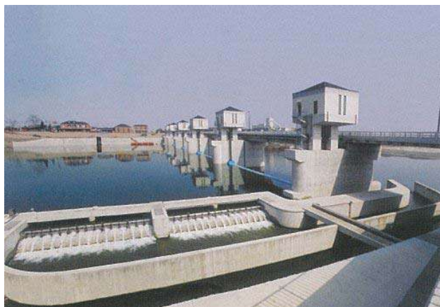
写真 5-4 六堰頭首工と流水改善水路（手前）
