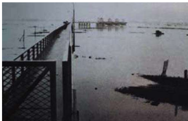
写真 4-6 秋ヶ瀬取水堰（志木市）
