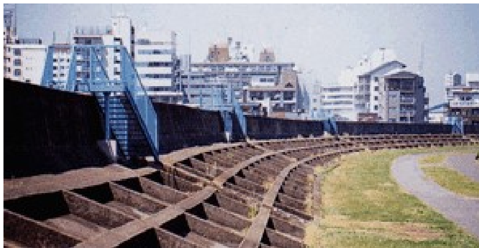
写真 4-20 荒川の高潮堤防
