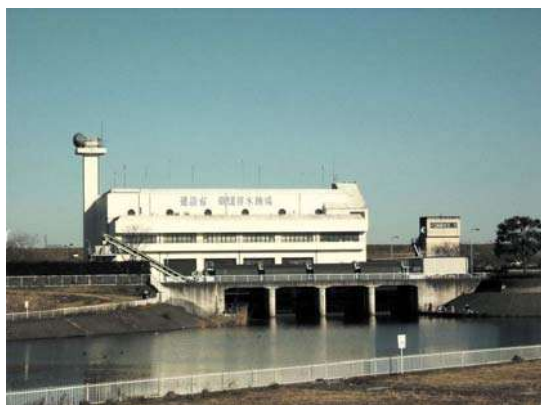
写真 4-13 南畑排水機場
