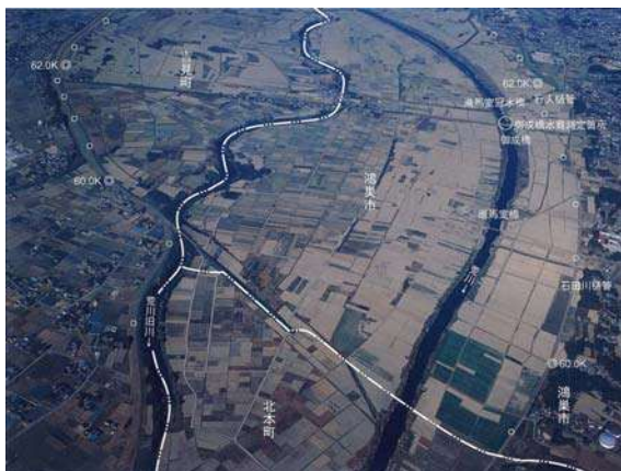
写真 8-6 御成橋付近（61.0k 付近）
