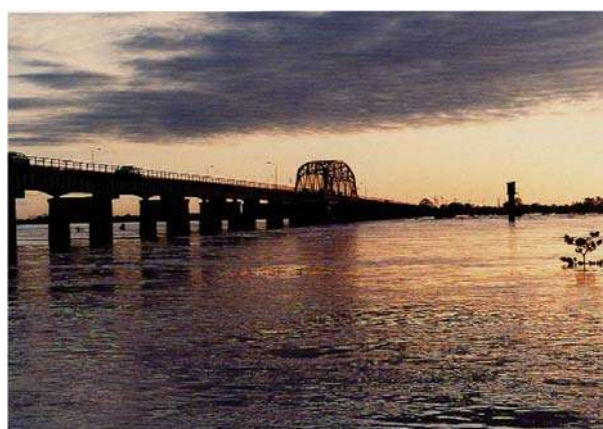
写真 4-8 治水橋（さいたま市）
