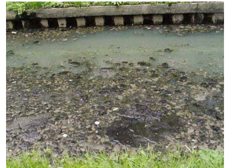
写真 6-2 水質汚濁の進んだ菖蒲川
