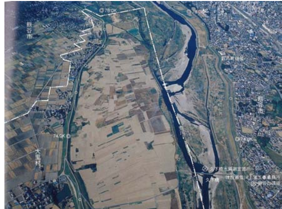
写真 8-5 久下橋（74.0k 付近）
