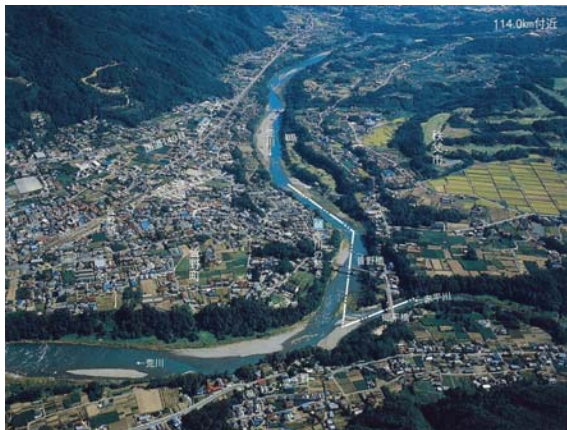
写真 8-2 赤平川合流部（114.0k 付近）
