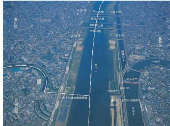
写真 8-8 京成押上線下流（7.0k 付近）
