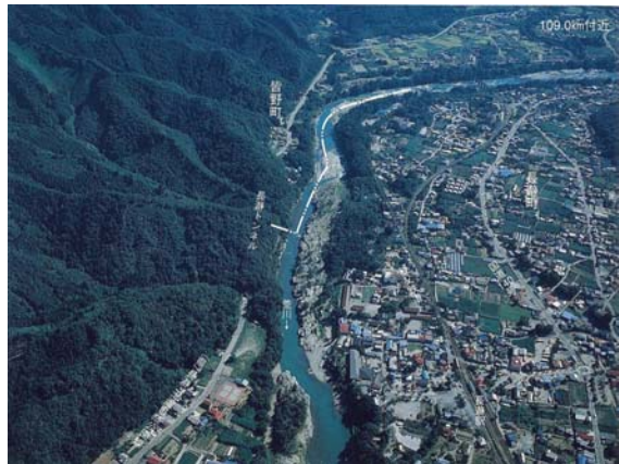
写真 8-3 長瀬（109.0k 付近）
