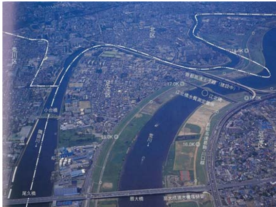
写真 8-9 扇大橋（15.0k 付近）
