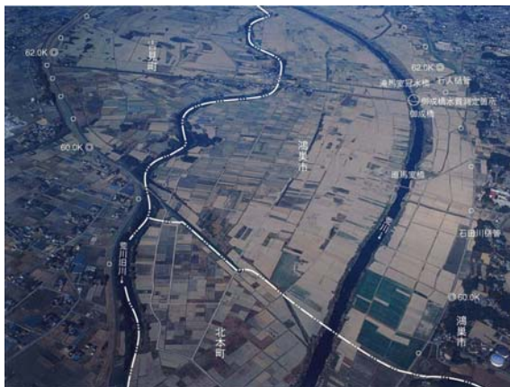
写真 8-6 御成橋付近（61.0k 付近）
