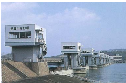
芦田川河口堰（昭和56年6月完成）
