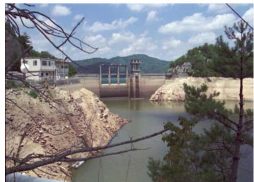
平成 6 年渇水 (三川ダム)
