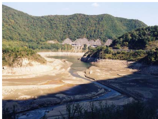
平成 14 年 渇水 ( 八田原ダム )
