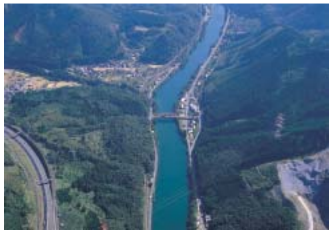
筑後川（夜明大橋付近）▶
