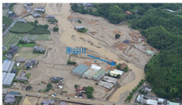
平成 29 年 7 月出水により被災した赤谷川 （朝倉市）
