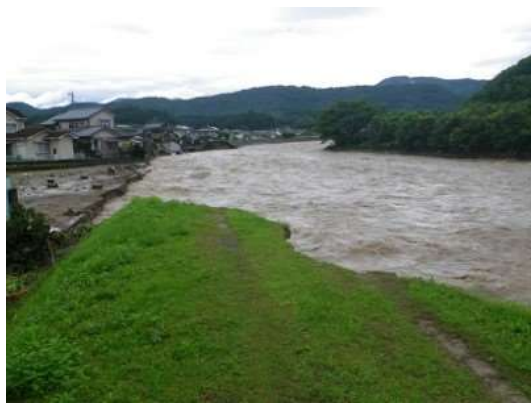
洪水により決壊した堤防（日田市）
