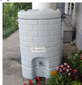
図 4-6 雨水貯留タンク
