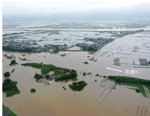
巨瀬川浸水状況（久留米市）
