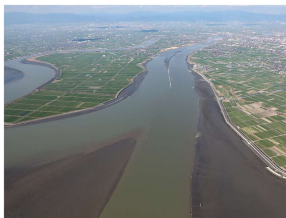
下流部（河口付近）
