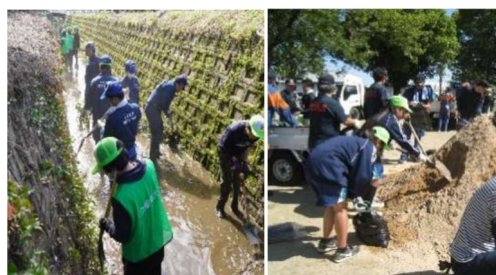
図 4-7 協働による水路の浚渫
