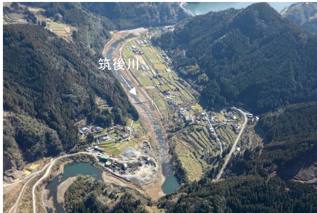
◀ 図 2-2-1 筑後川上流部 (松原ダム下流)
