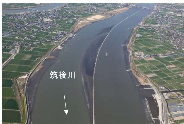
図 2-2-8 筑後川下流部 ▶ (河口より 1.5km 付近)
