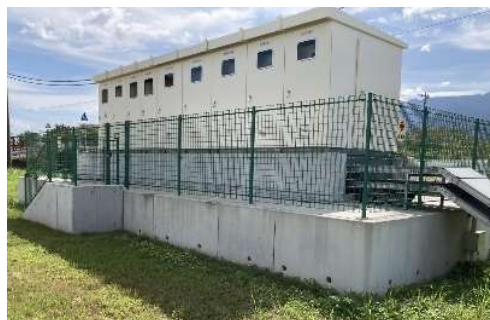
図 4-10 屋外受変電設備の嵩上げ
