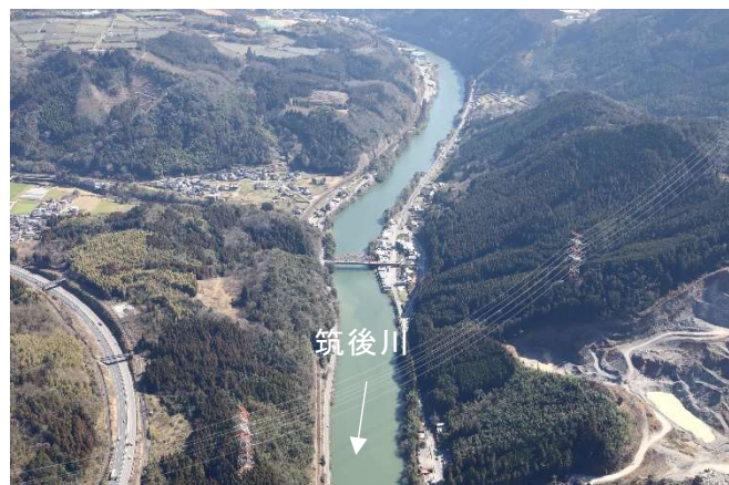
図 2-2-2 筑後川上流部 ▶ (夜明大橋付近)
