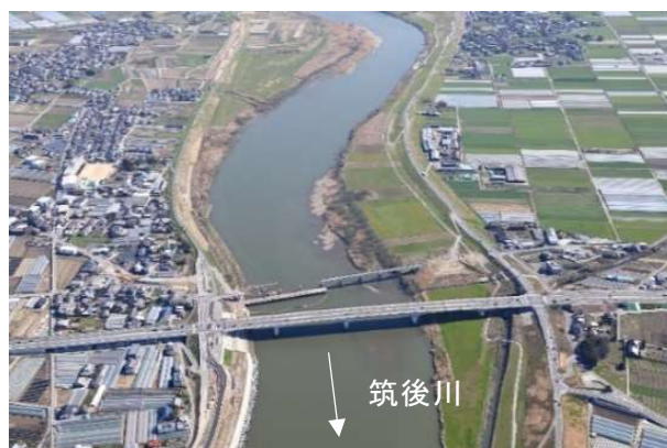
図 2-2-5 筑後川中流部 ▶ (神代橋 くましろ 付近)
