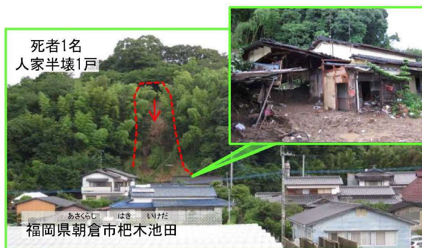
図 2-1 平成 24 年 7 月豪雨時のがけ崩れによる被害状況
