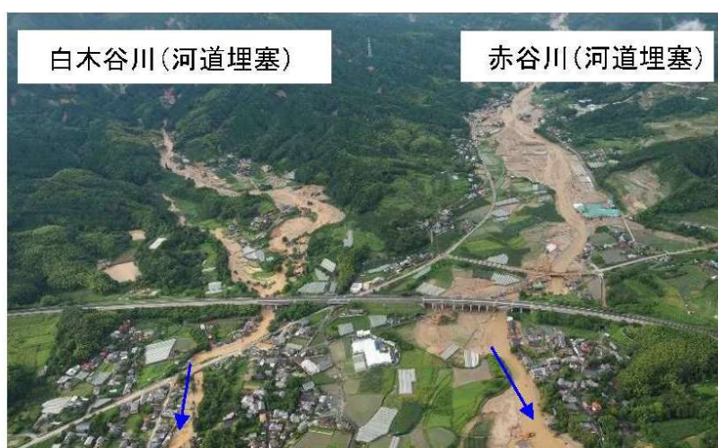
図 2-2 平成 29 年 7 月豪雨時の赤谷川、白木谷川の被害状況
