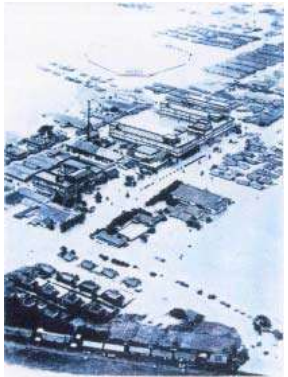
久留米大医学部付近の浸水状況
