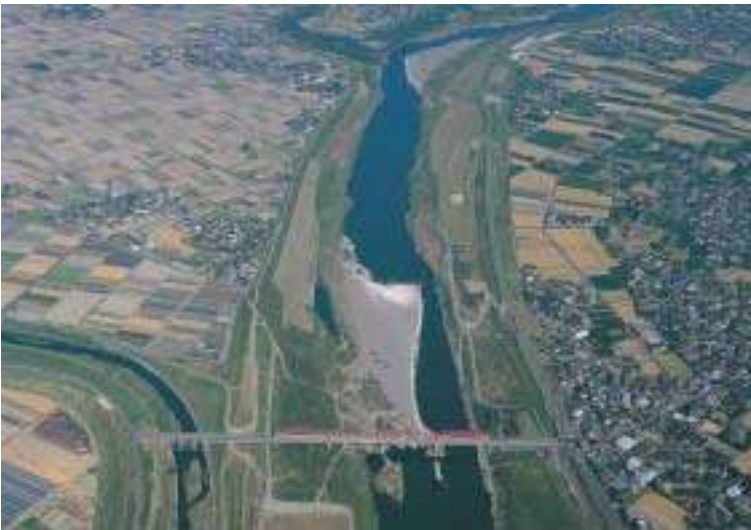
◀ 中流部（筑後川橋付近）
