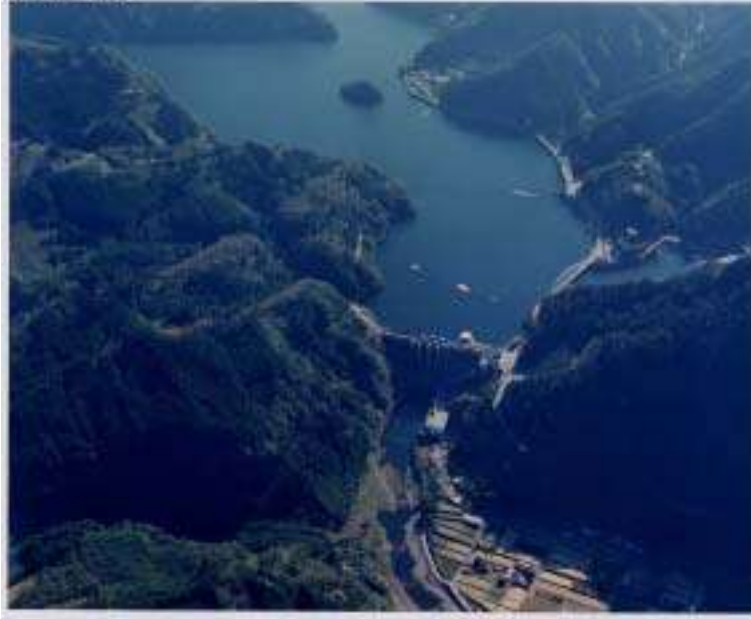
◀ 上流部（松原ダム付近）
