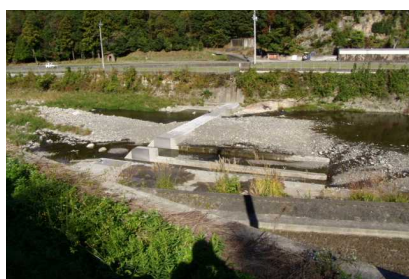
▲天川頭首工（左岸から撮影） 河川水の 2.5\text{m}^3/\text{s} 超過分の最大 8\text{m}^3/\text{s} 取水 取水した水は満濃池に導水
