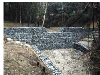
復旧治山工事状況
