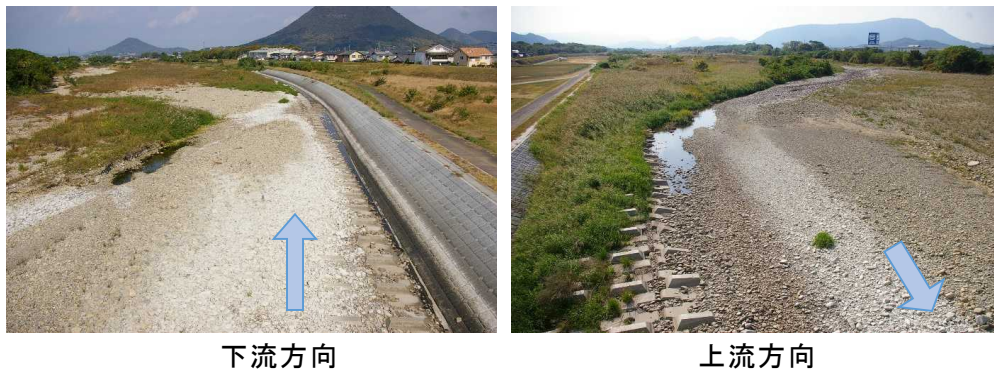
図 6.1.3 中方橋上下流の瀬切れ状況（令和5年10月27日）
