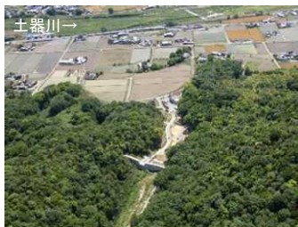
砂防堰堤（榎林川）
