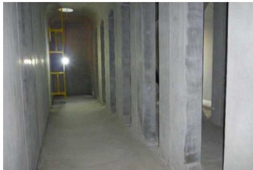
雨水貯留槽の内部状況（宇多津町）
