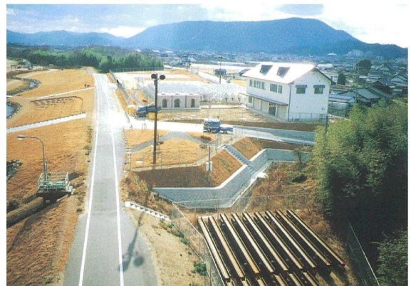
垂水河川防災ステーション
