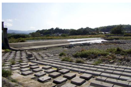
一 大川頭首工（右岸から撮影） ・最大 2.8\text{m}^3/\text{s} 、年間 1,440 万 \text{m}^3 取水（届出書） ・河川水 2/3 取水、 1/3 を下流へ分水 ・ 2/3 取水の内 1/4 は左岸へ分水（覚書） ・取水した水は右岸の溜池群（仁池、打越池、大窪池、小津森池）に貯留し、かんがい補給を行っている
