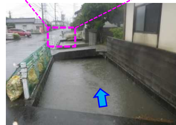
大雨時の水路状況
