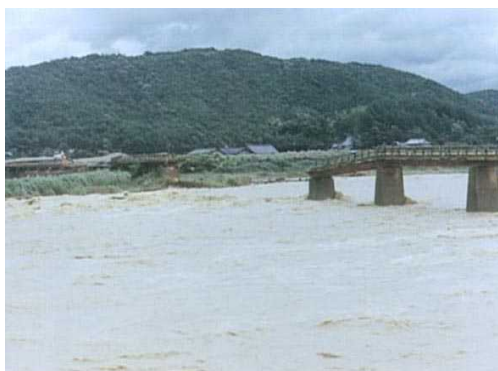
旧乙井橋（11.6k 付近）流出
