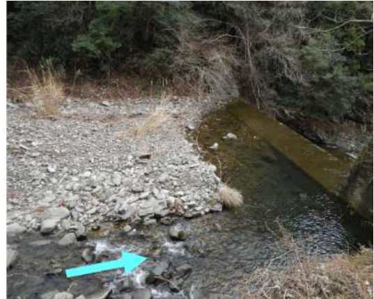
写真② 久保谷堰堤
