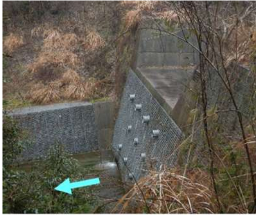
写真① 野田小屋川堰堤
