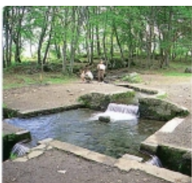
19 ハヶ岳南麓湧水群 長坂町小笠原の「三分一湧水」は湧水群の代表的なもので、農業用水として三等分に配水している。
