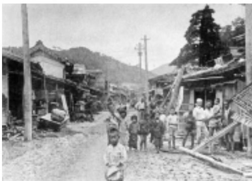
明治40年洪水(鯉沢浸水の惨状)
