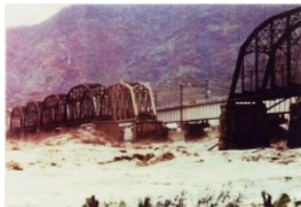
昭和57年洪水(JR富士川鉄橋の落橋)
