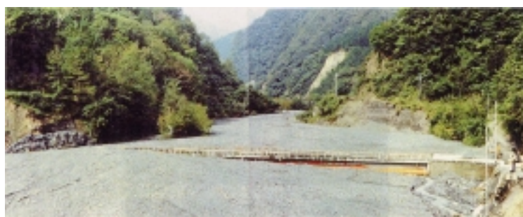
流出土砂が多く、河床が上昇し橋梁が埋没した。(早川)
