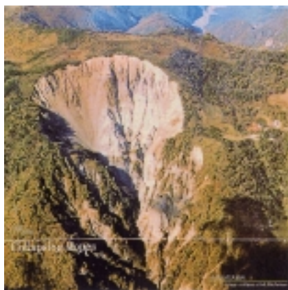
七面山では山地崩壊が甚だしい。
