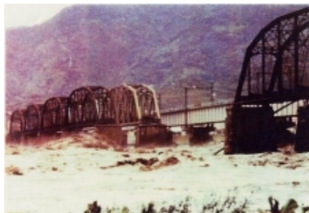
◆昭和57年洪水（JR富士川鉄橋の落橋）
