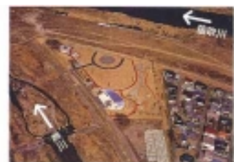
●富士川防災公園 平成7年度（1）防災整備の地域性利用して完成した。この地域の富士川公園として利用され、洪水時には防災拠点として使用される。 （防災拠点区域）1,000㎡ 富士川公園区域（4,200㎡）
