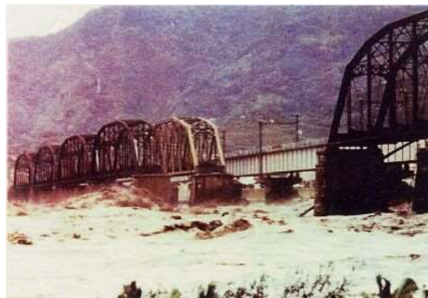
写真 4-9 昭和57年（1982年）洪水（JR富士川鉄橋の落橋）
