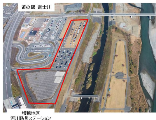
写真 8-5 増穂地区防災ステーション
