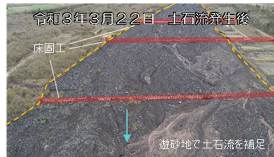
図 2-3 大沢川遊砂地に流下した 2m を超える巨石
