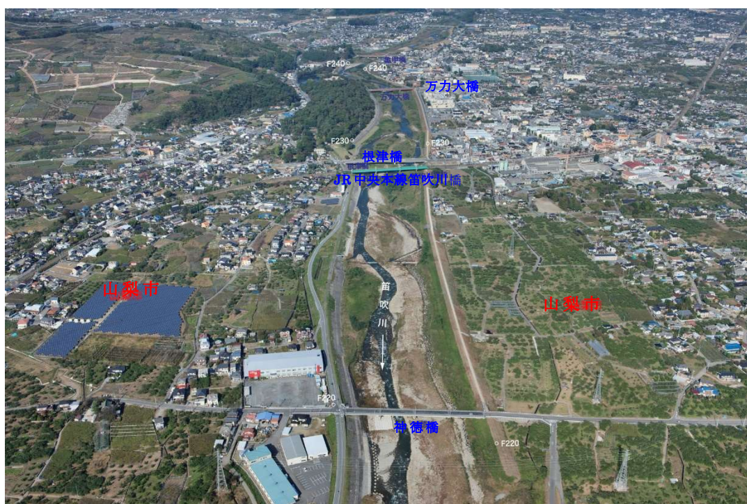
图 4-2 笛吹川 根津橋上流万力林付近(F230 付近)
