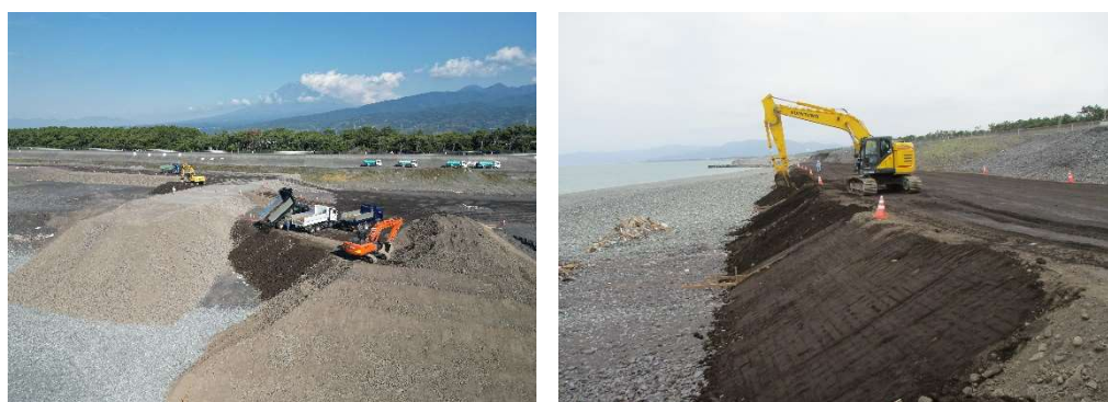
図 5-3 養浜工の実施状況
