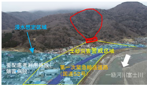
土石流対策 下天神沢川(山梨県)
