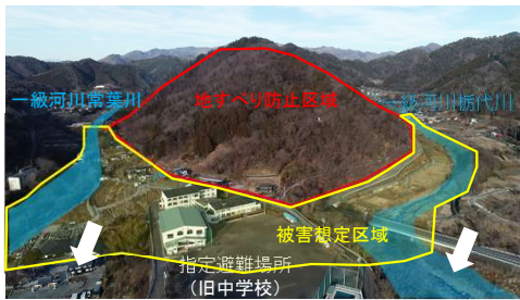
地すべり防止対策 五条地区(山梨県)
