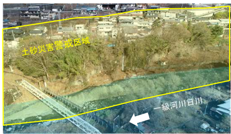
急傾斜地崩壊対策 丸林地区(山梨県)
