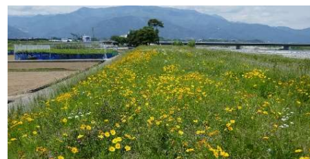
被度3 (釜無川79kp付近右岸 堤防) R3.5.25撮影
