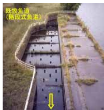
【既設魚道：階段式魚道】
