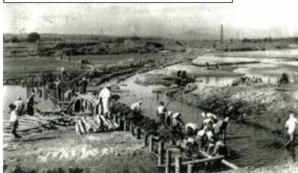
昭和25年の旧馬淵川締め切り工事
