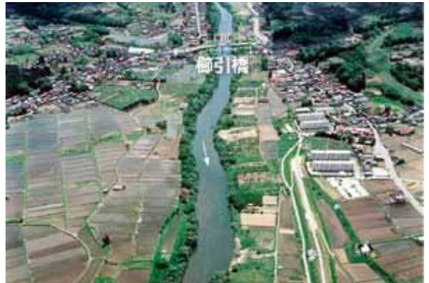
河道の様子(櫛引橋～尻内橋の間)
