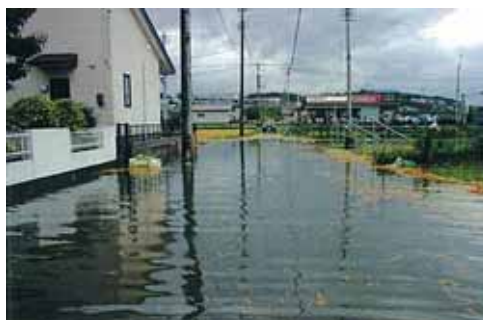
【八幡・尻内地区の浸水状況】
