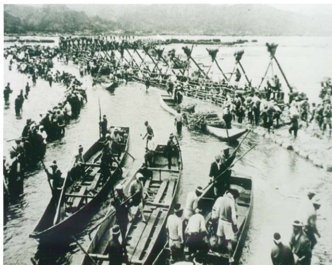
出雲結による水止め作業 (昭和9年9月 出西村阿宮堤 しゅっさいむら あぐ )
