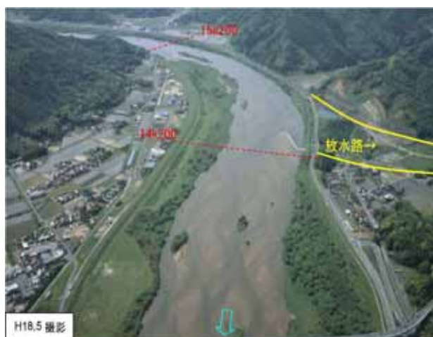
図 5.1.1 斐伊川本川分流部付近の状況
