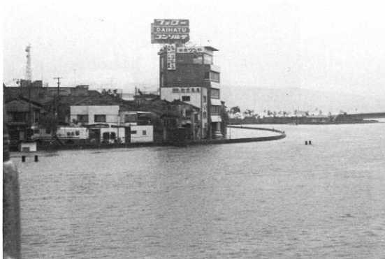
昭和 47 年 7 月出水 宍道湖の水位上昇の状況 (松江市魚町)
