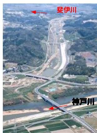
斐伊川放水路開削部の状況
