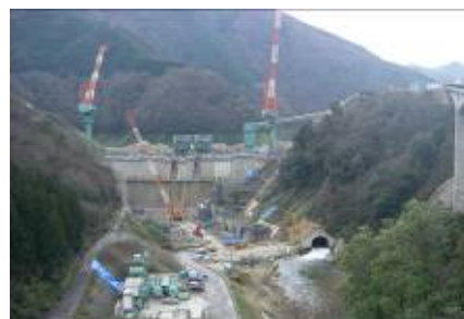
志津見ダム(本体工事状況)
