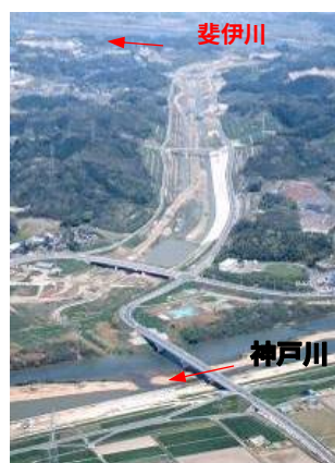
斐伊川放水路開削部の状況
