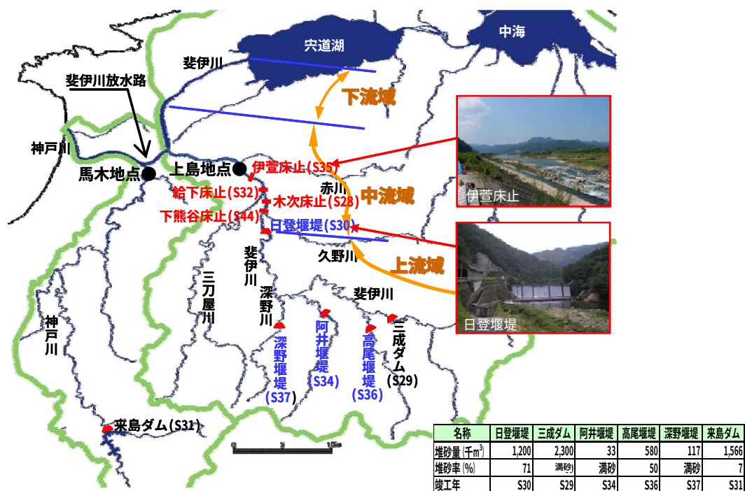
図 8.3.3 砂防堰堤の堆砂の状況
