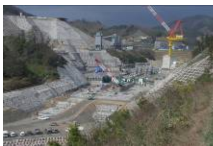
尾原ダム(本体工事状況)
