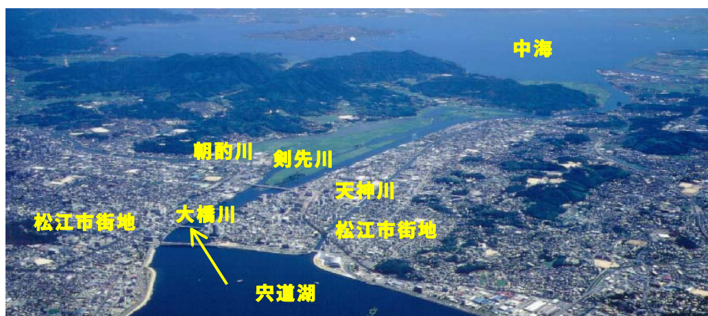
大橋川全景(上流から望む)
