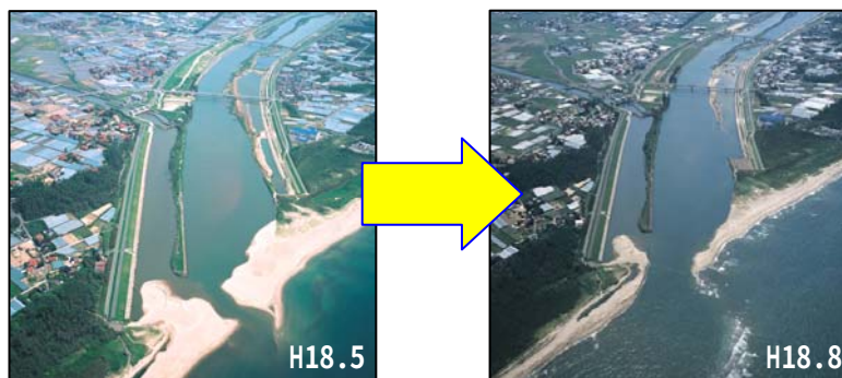
図 8.4.3 神戸川河口砂州の状況（H18.7 洪水前後の比較）
