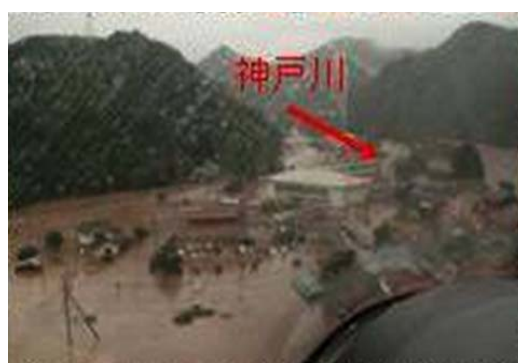
神戸川の被災状況(出雲市所原)
