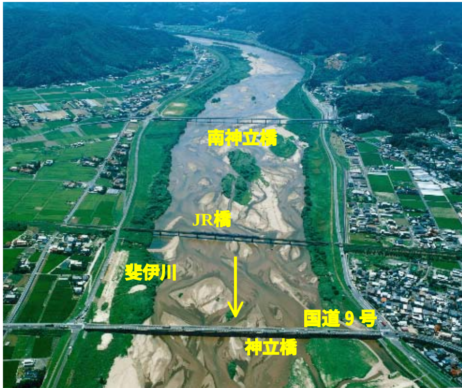
斐伊川下流部（出雲市大津付近）
