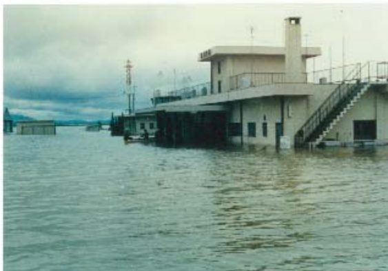
昭和 47 年 7 月出水 出雲空港の浸水状況(10 日間閉鎖)
