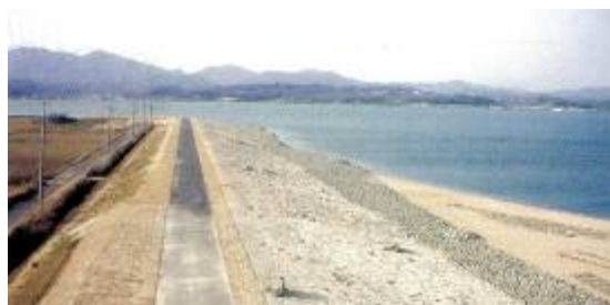
湖岸堤の整備状況
