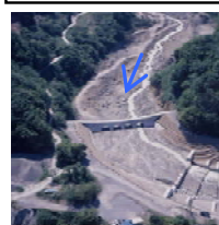
ス-パ-暗渠砂防えん堤(浦川)
