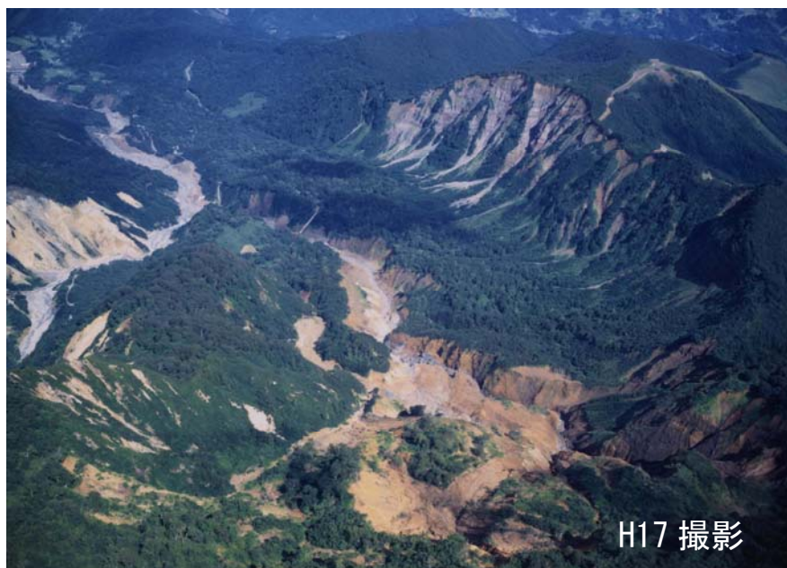
写真 稗田山の崩壊状況
