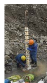
洗掘センサーによる河床変動量調査
