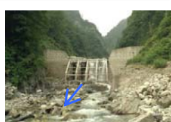
鋼製砂防えん堤(松川)
