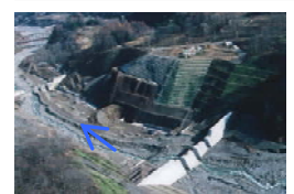
スリット型砂防えん堤(浦川)
