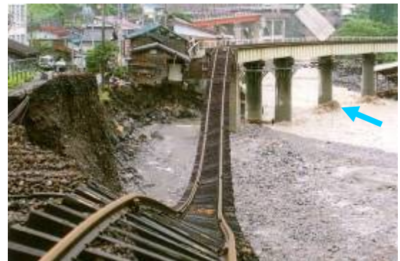
JR大糸線被災状況（糸魚川市平岩地先）
