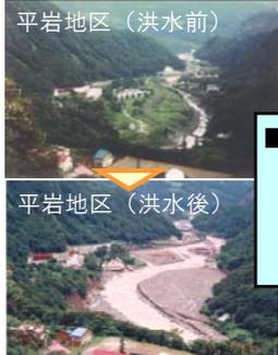
■平岩地区だけでも約100万m<sup>3</sup>の土砂が堆積
