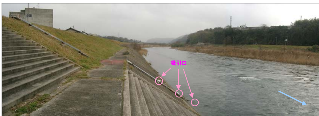
図 8.3 大殿地点におけるポンプ採水状況 (日野川本川 10.0k 付近)
