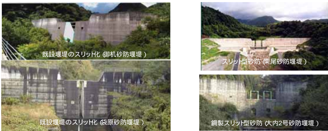
図 8.4.11 砂防堰堤の整備状況
