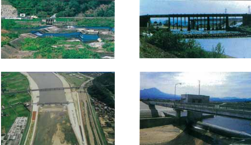
図 4.3.3 日野川堰と法勝寺川堰（上段：改修前、下段：改修後）
