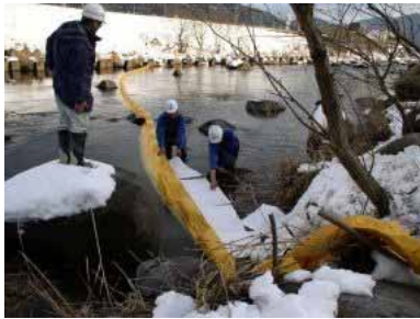
オイルフェンス設置状況
