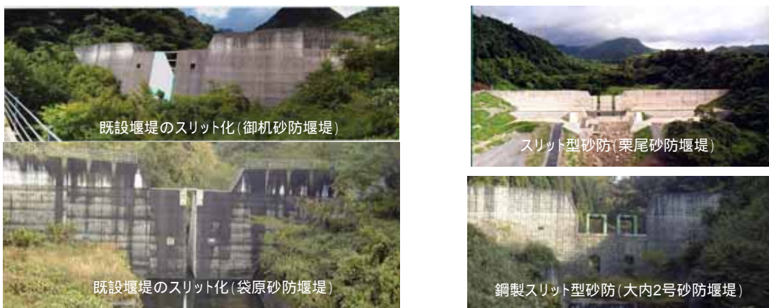
図 8.4.11 砂防堰堤の整備状況
