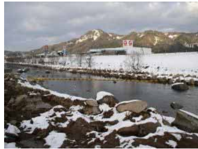
オイルフェンス設置後
