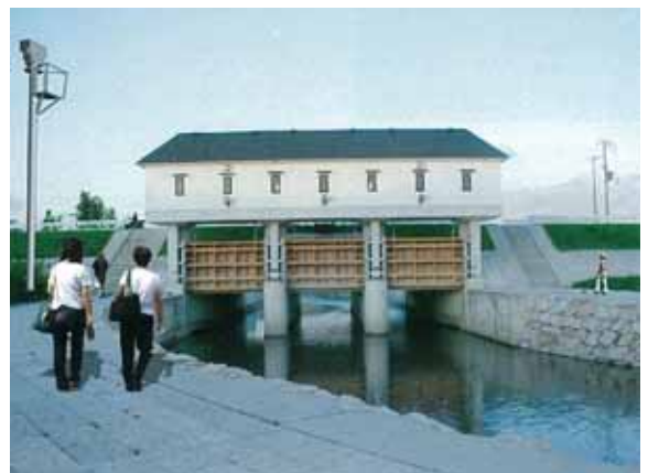
図 - 9.5 樋門付近の CCTV 監視カメラ
